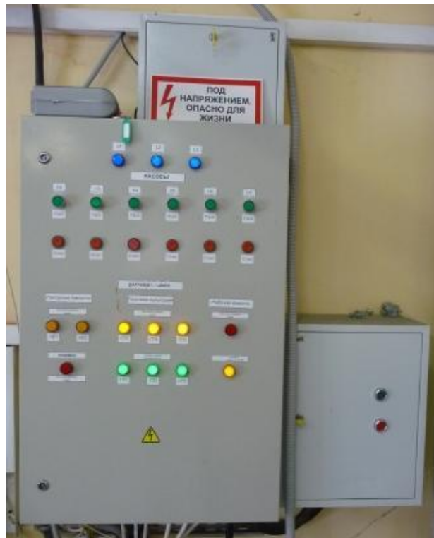
Рис.4.1.3.Шкаф управления насосами и автоматикой
